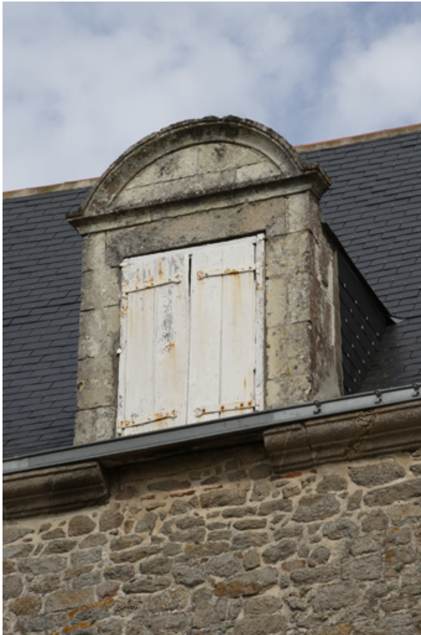
Logis. Façade antérieure. Détail de la lucarne de gauche.
