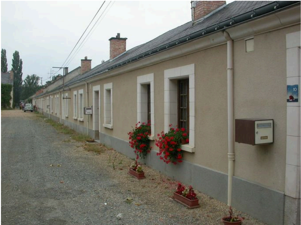
Elévation antérieure des logements ouvriers de la papeterie.
