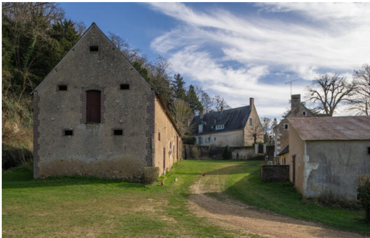
La ferme : vue d'ensemble.
