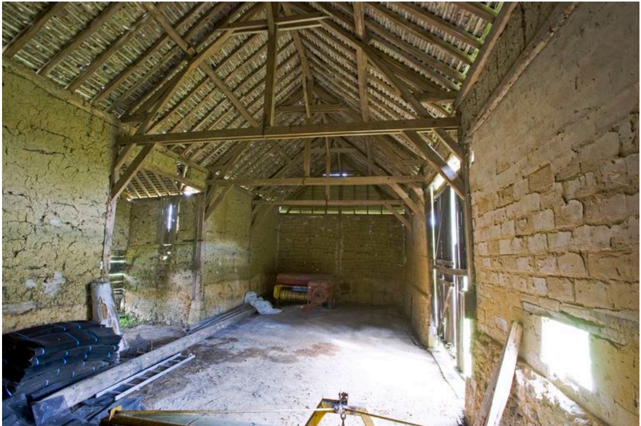
Les Bommeries : vue intérieure de la grange.
