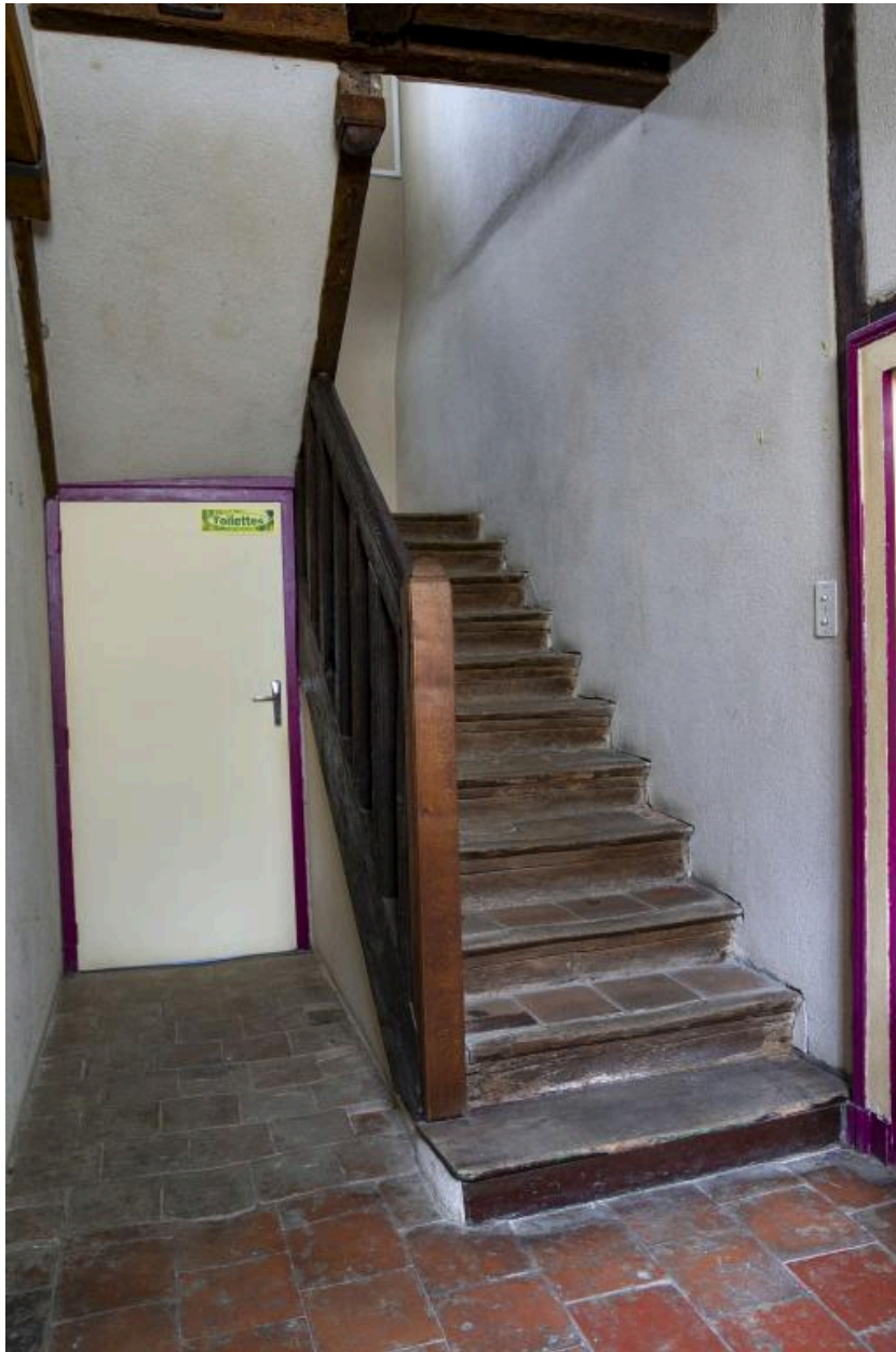
L'escalier au rez-de-chaussée.
