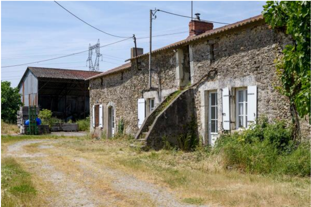
La Jolivetière. Ferme n° 1. Vue du logis depuis le sud-est.
