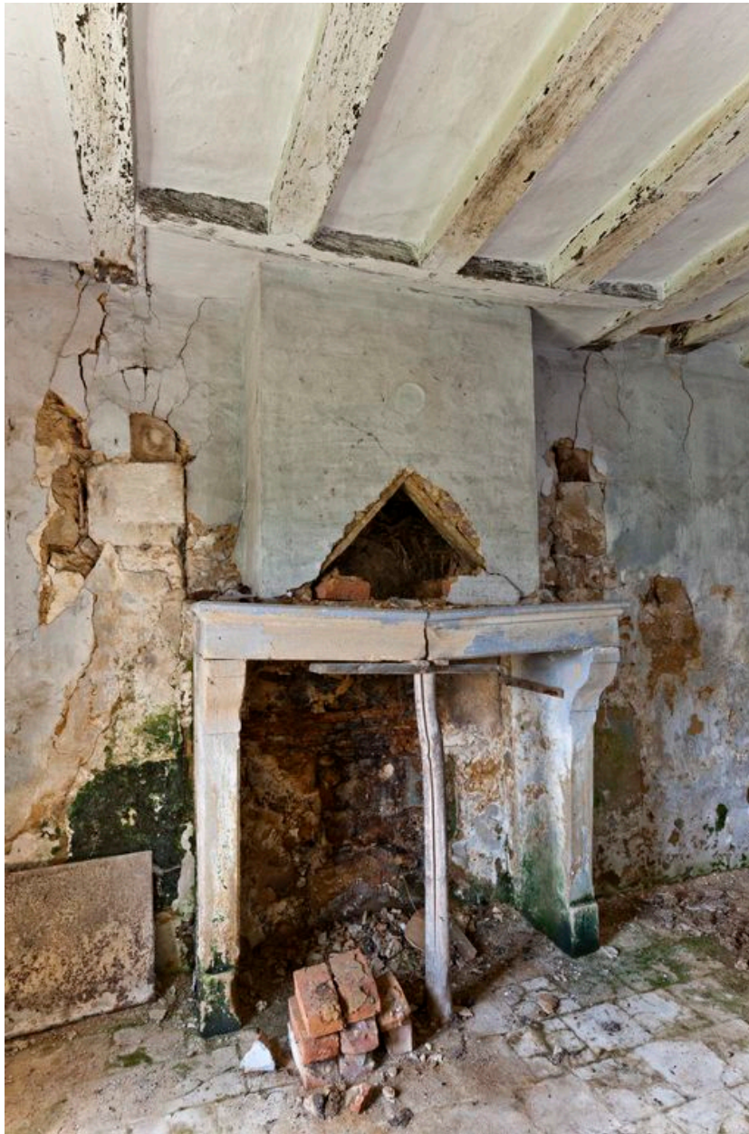
Cheminée de la pièce gauche. Les deux consoles bûchées de part et d'autre et la trémie dans le plafond marque l'emprise de la hotte cheminée antérieure à 1835.
