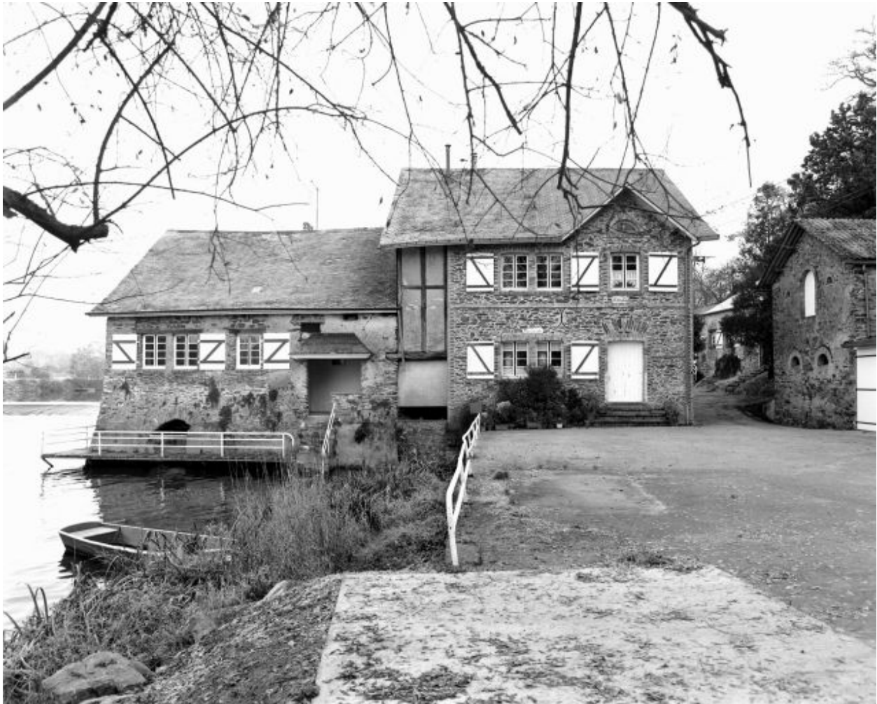
Façades sud (aval) des moulins à farine et à tan. A droite, pignon ouest de l'ancienne étable à vache. Au fond, l'ancien logis.
