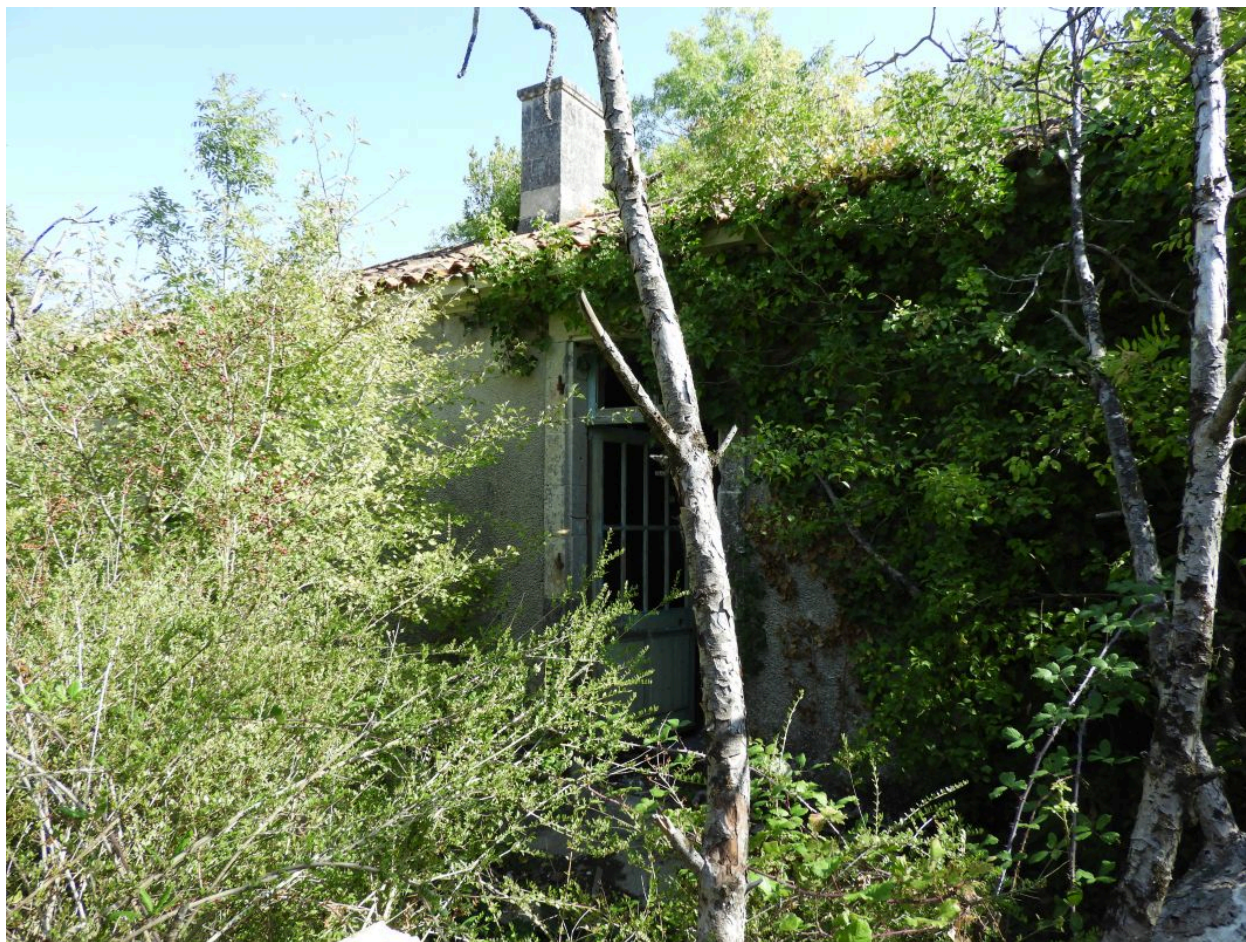
La maison de garde de l'écluse, sur la rive gauche de celle-ci, vue depuis le sud-ouest.
