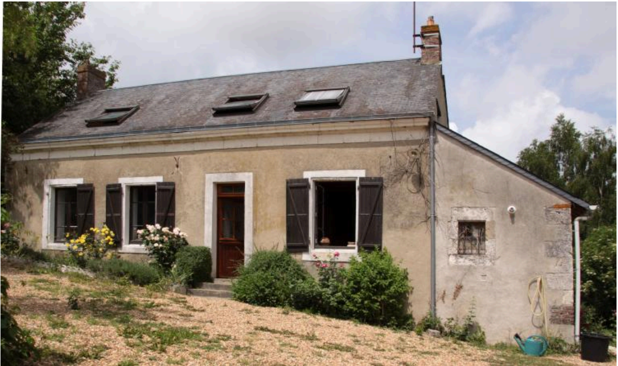
Maison. La Cormerie (1849).
