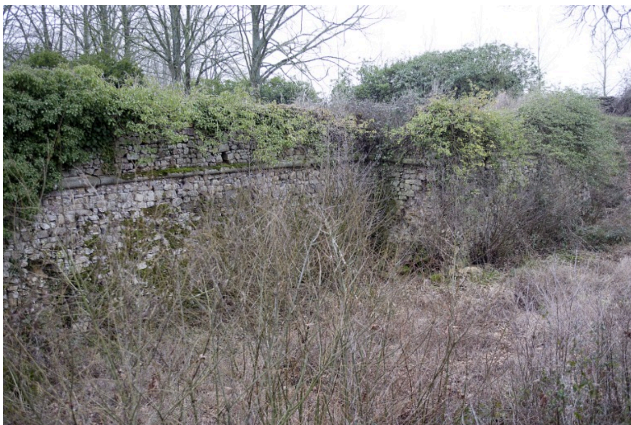
La douve ouest : la partie sud et le bastion sud-ouest vus depuis le nord-ouest.
