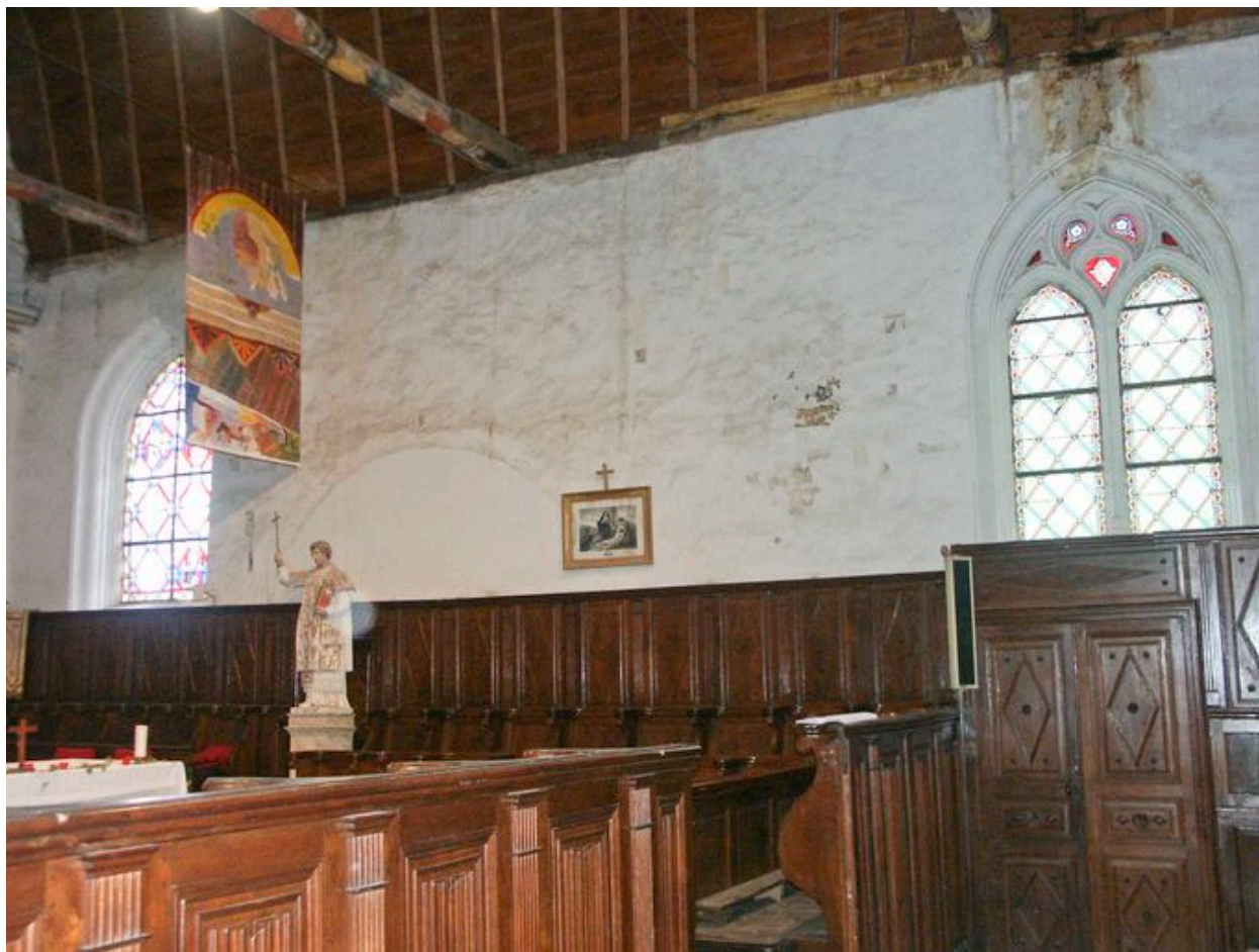
Chœur, mur sud : vue d'ensemble des fenêtres de sondage.
