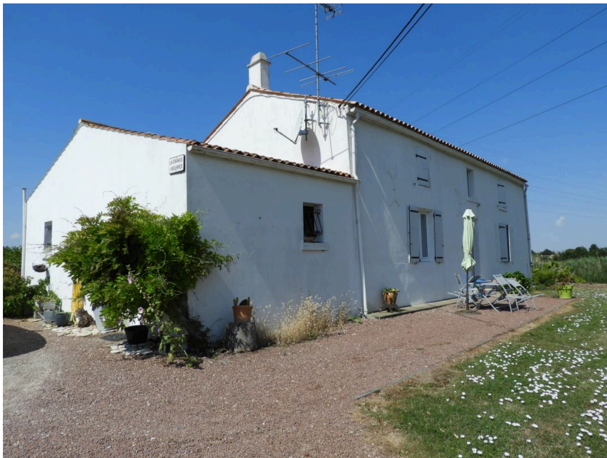
Le logis vu depuis l'est.
