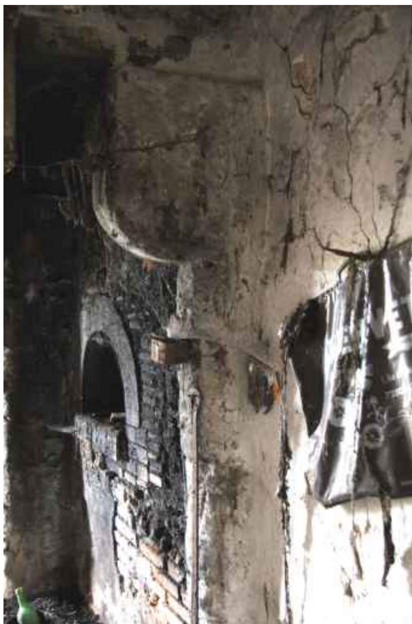
Maison 2, chambre à feu : piédroit de la cheminée.
