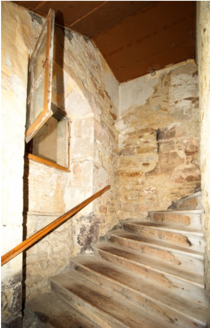
Vue de l'escalier, jambage de foyer et support d'angle.
