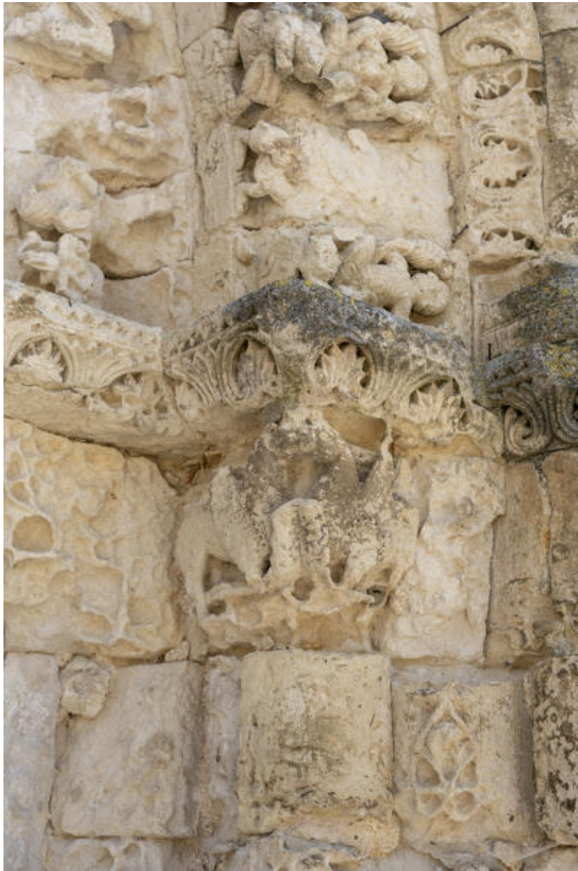
Détail du portail occidental.
