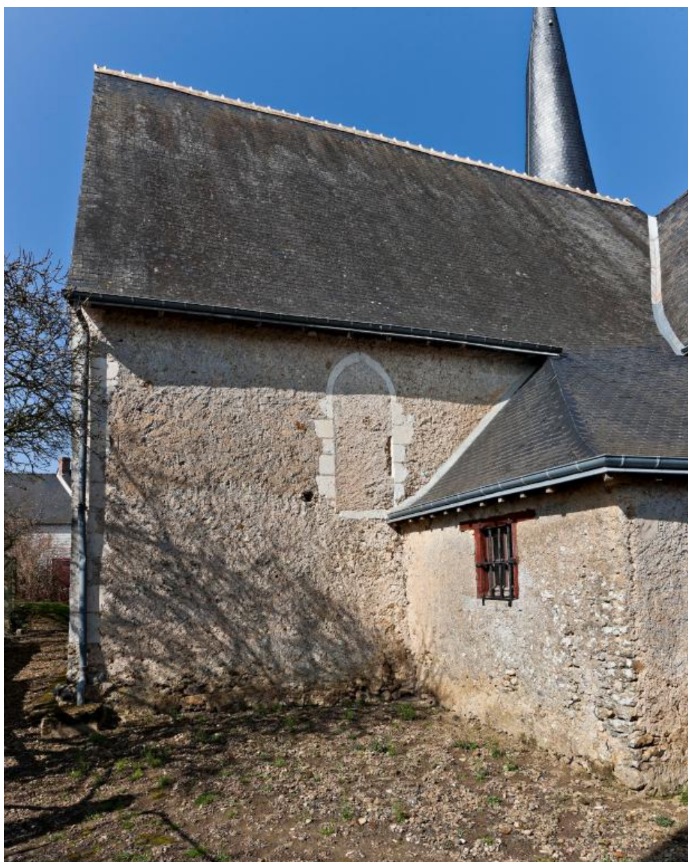
Chapelle de la Vierge et sacristie, vues depuis l'est.
