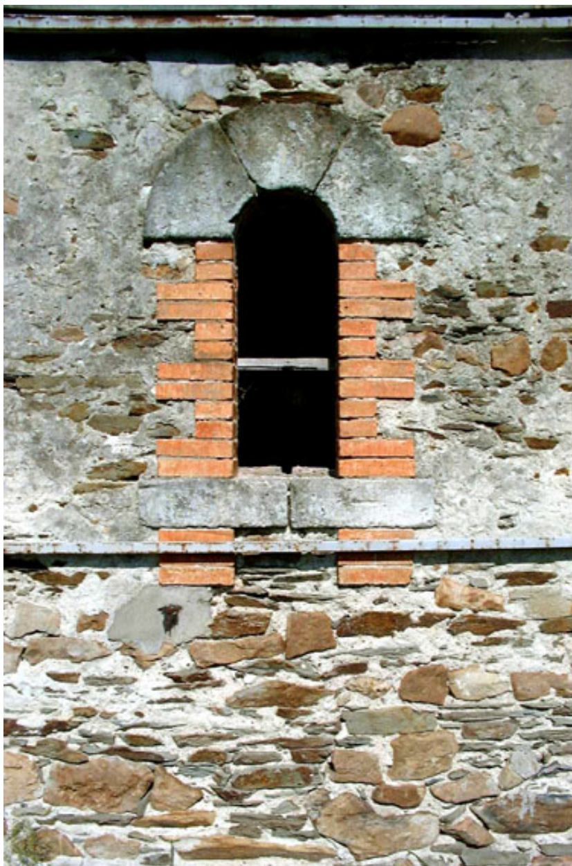
Détail d'une baie : montants en brique, arc en plein-cintre et appui en tuffeau.
