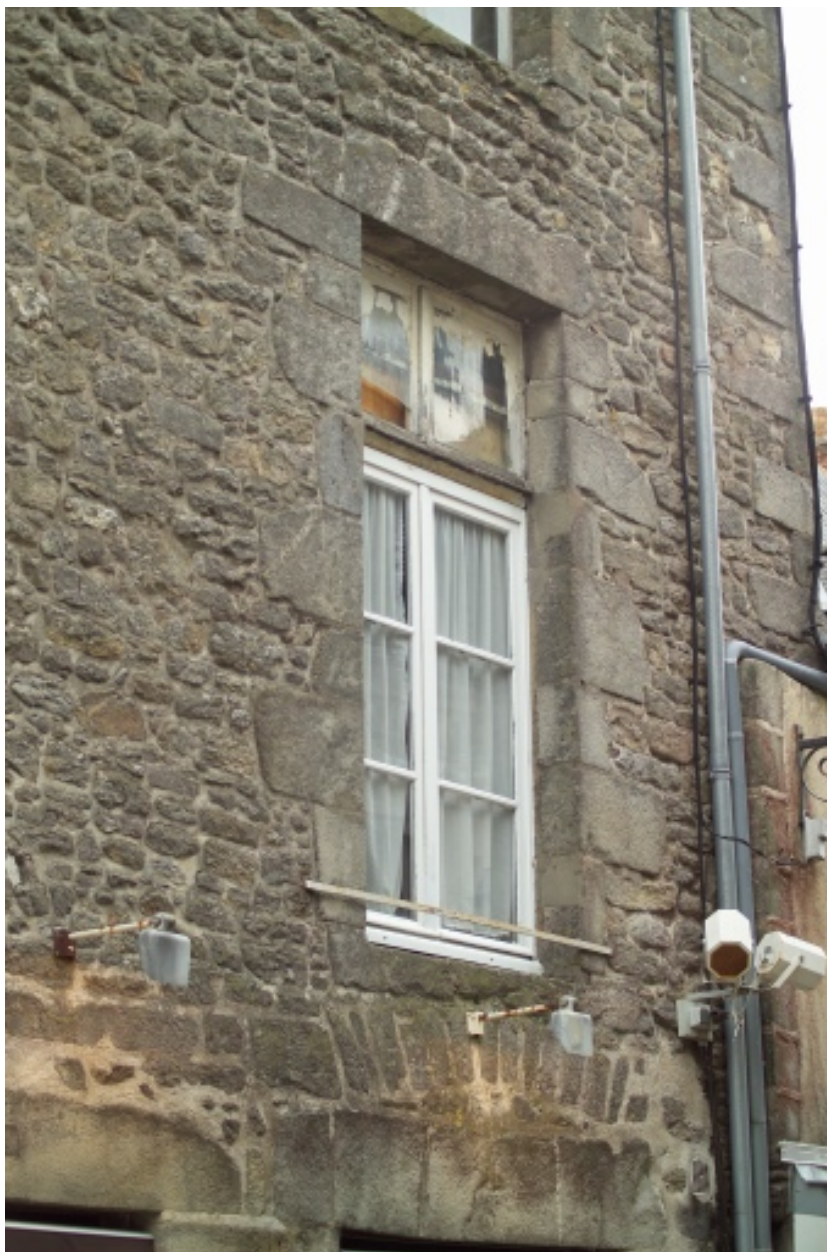
Façade sur la rue Saint-Michel, détail d'une fenêtre.
