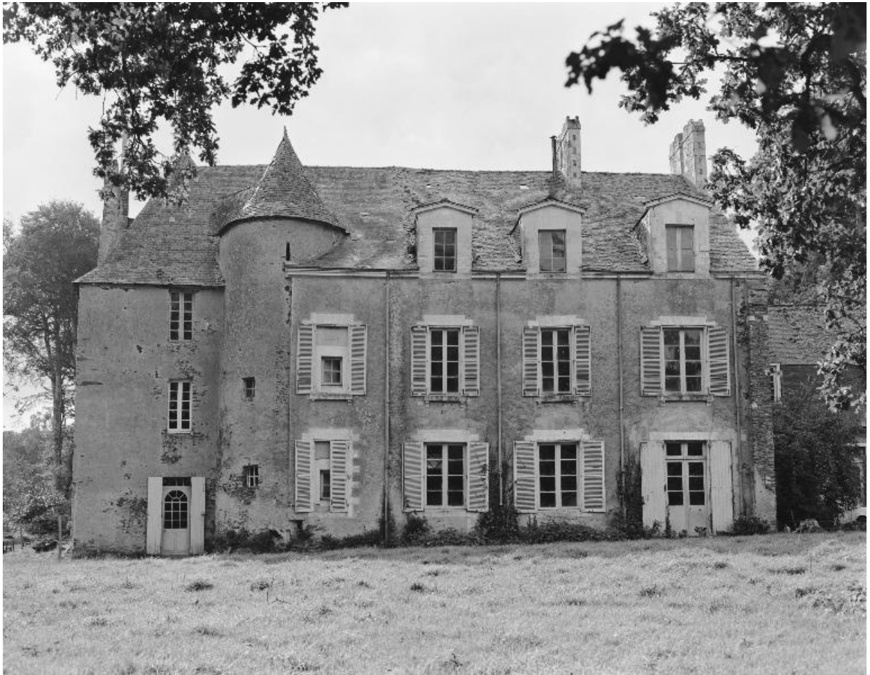
Maison de maître, façade ouest (1982).
