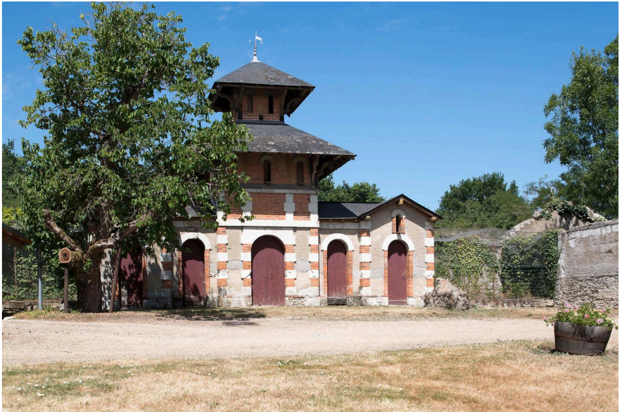
Vue de la volière depuis le sud-est.
