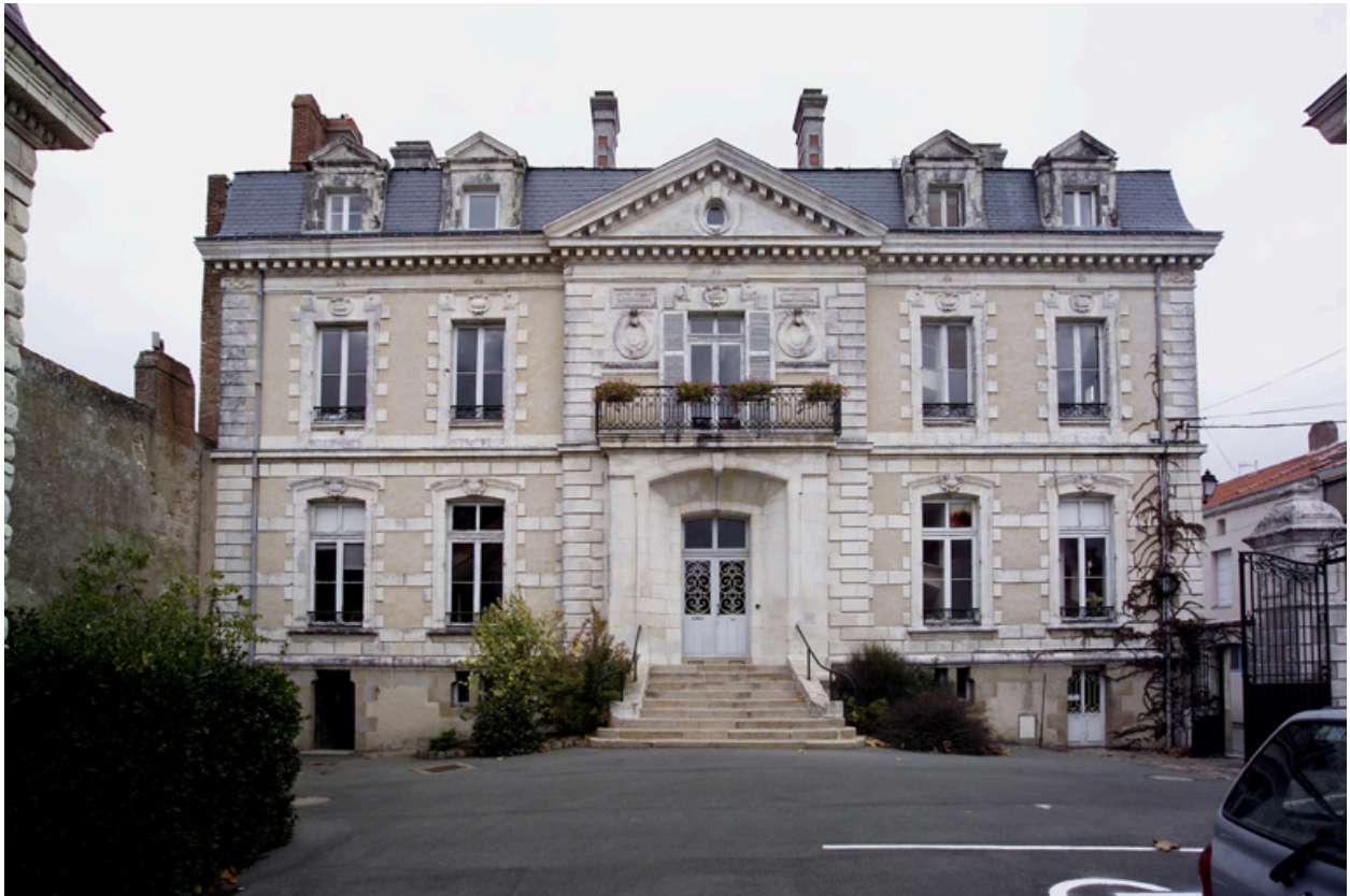
La façade sud.
