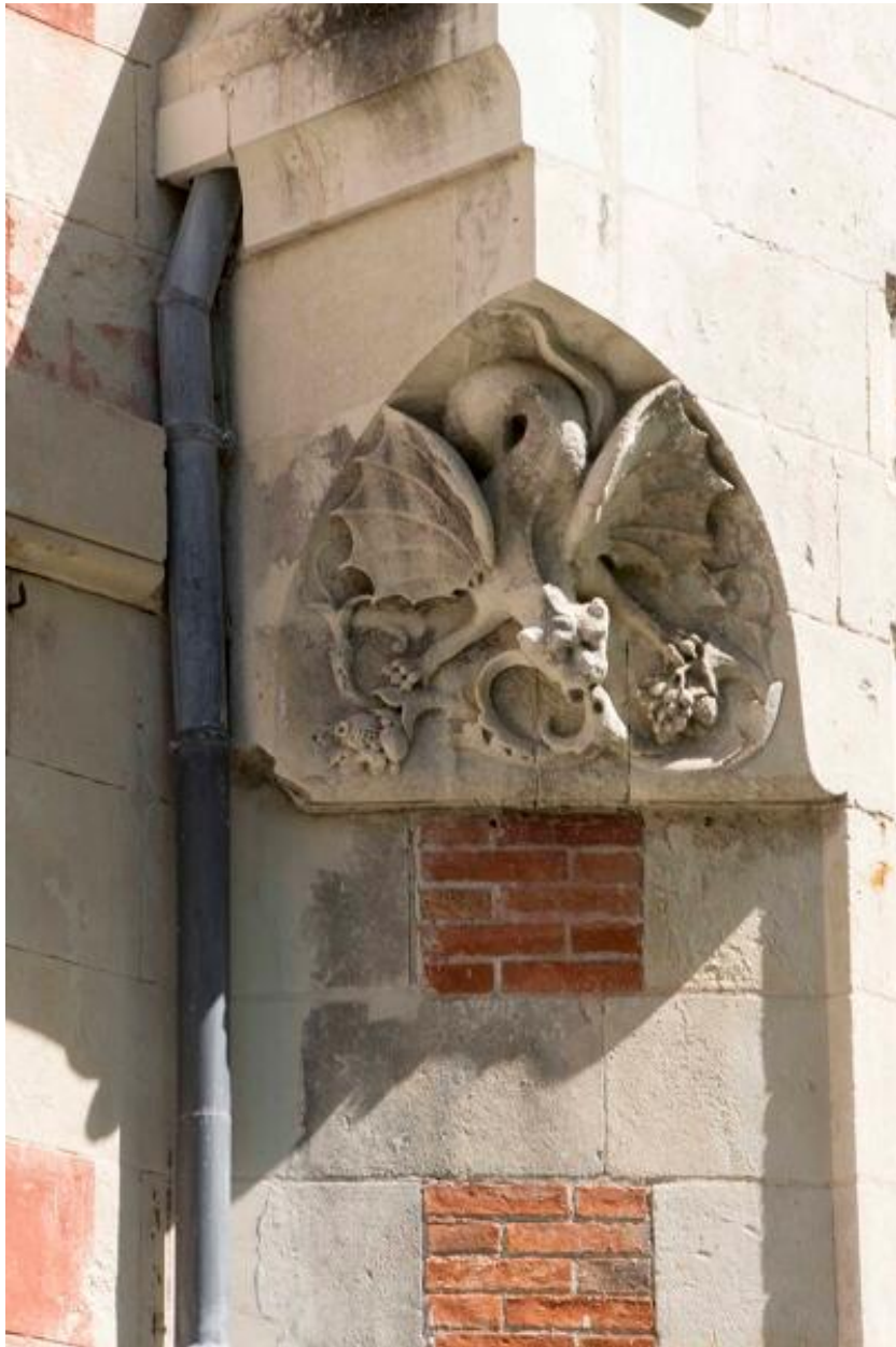
Amortissement ornée d'un bestiaire médiéval dans les angles des pavillons. Dragon.
