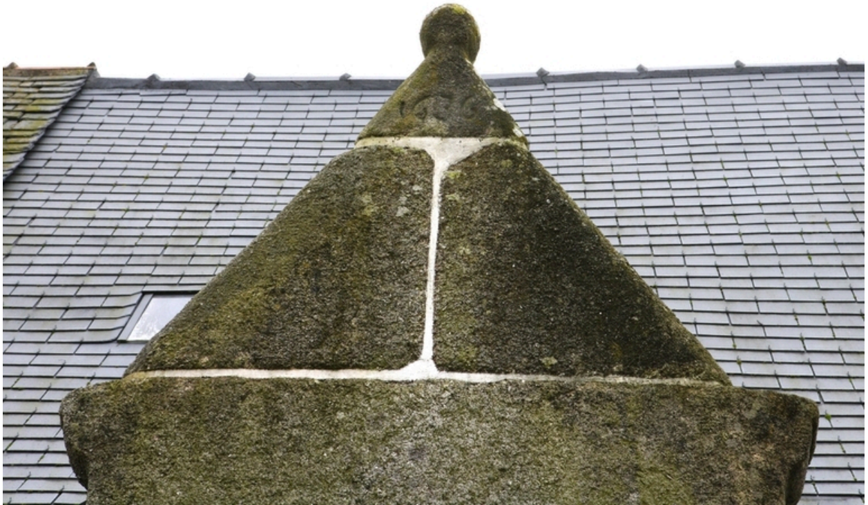
Détail du fronton de la lucarne daté 1636 (7 rue du Tenny).
