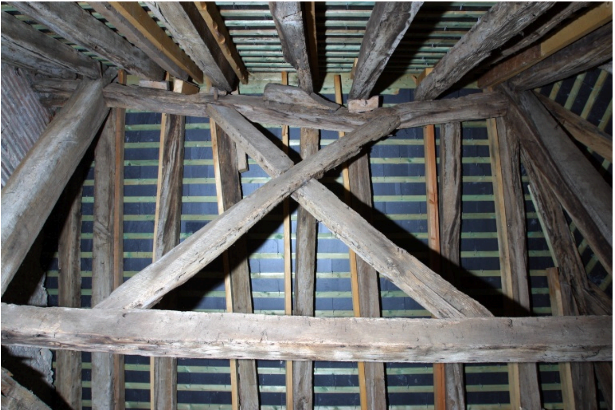
La charpente de la partie sud : faîtière, sous-faîtière, croix de Saint-André.
