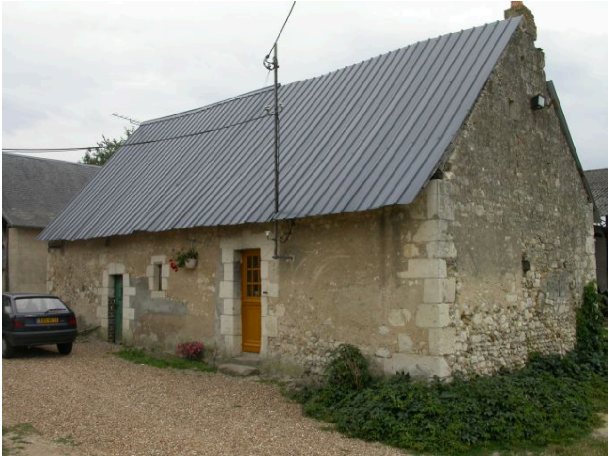
Maison 2 : façade sur cour.
