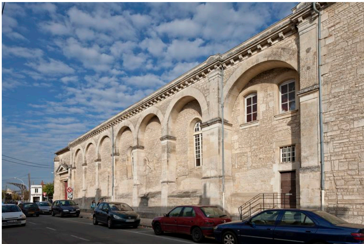
Façade sur rue de la chapelle.
