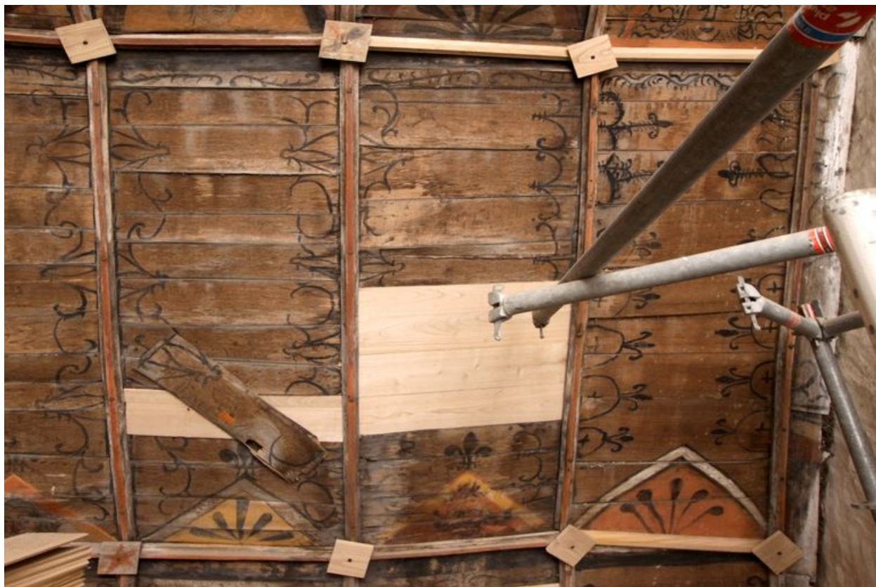
Nef, voûte lambrissée, côté nord, quatrième travée : registre médian après les travaux effectués en 2010.
