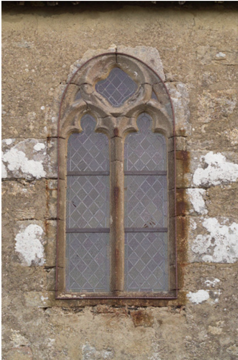
Baie dans le mur sud, partie est.
