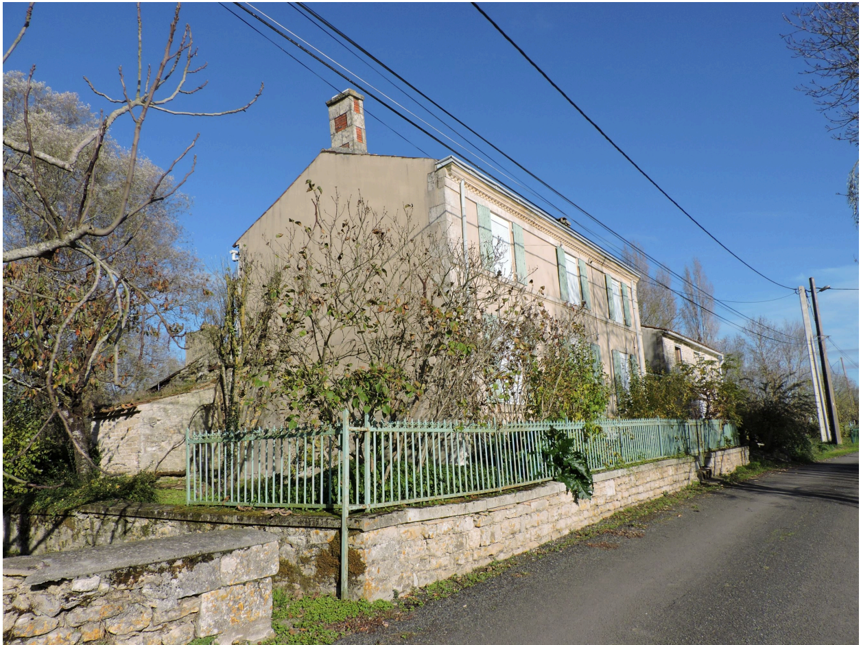
Le logis vu depuis le sud-ouest.
