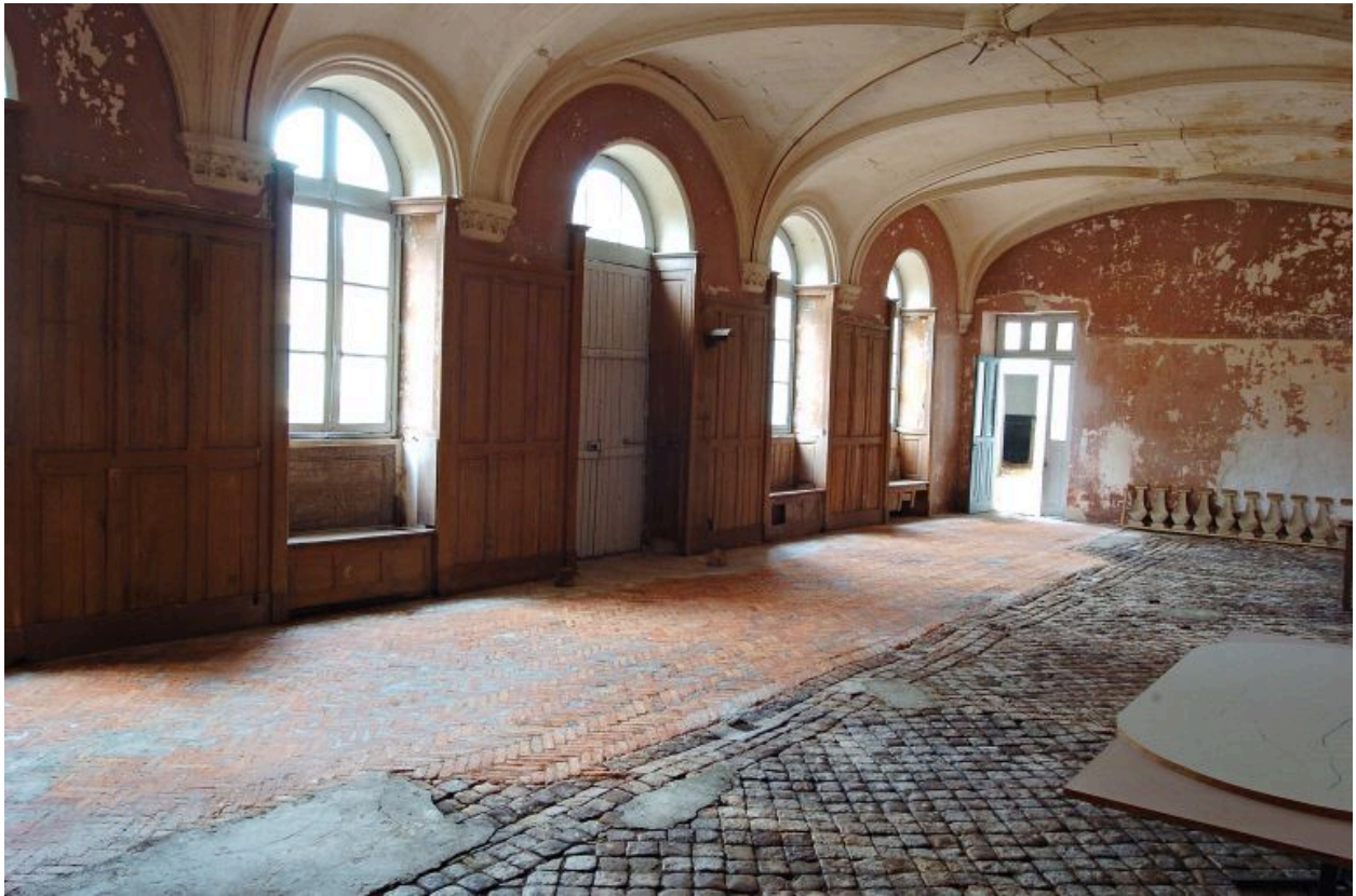
Les écuries du nouveau château : baies sur la cour.
