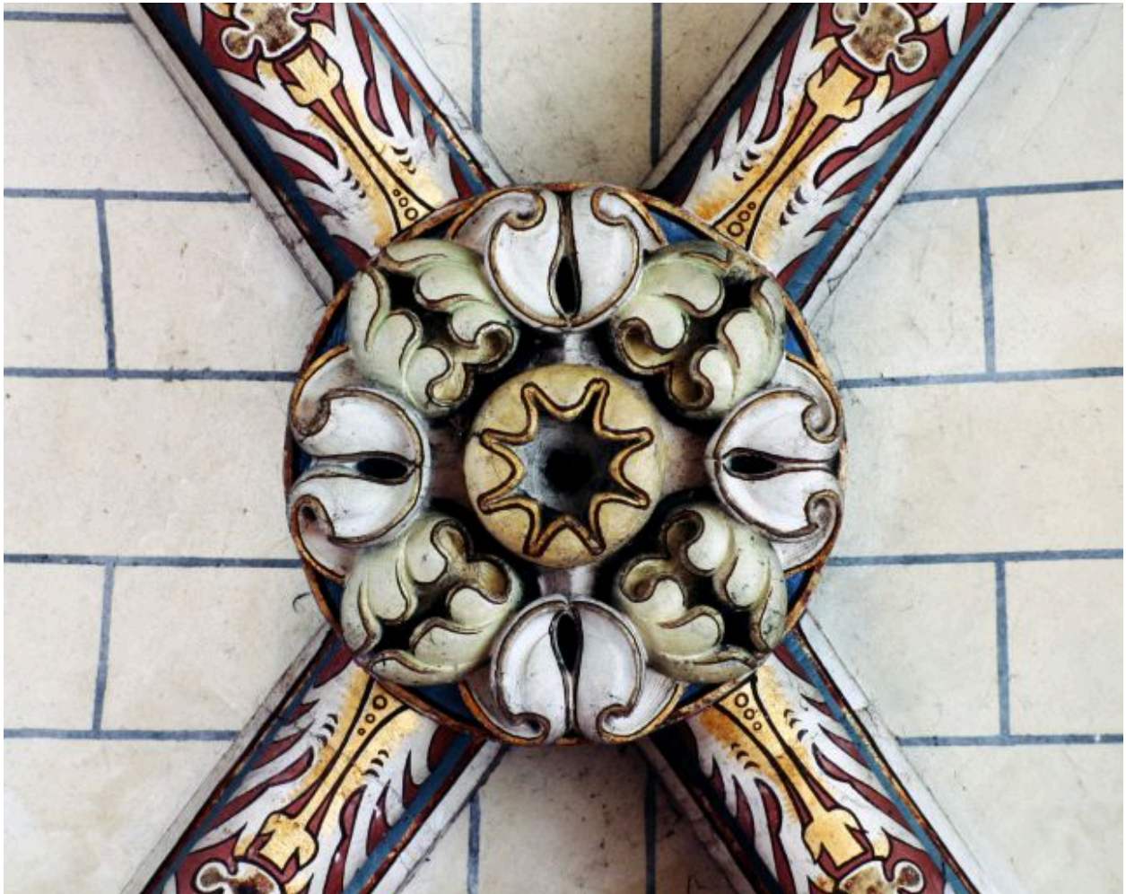
Premier étage, vue de détail : clef de voûte.
