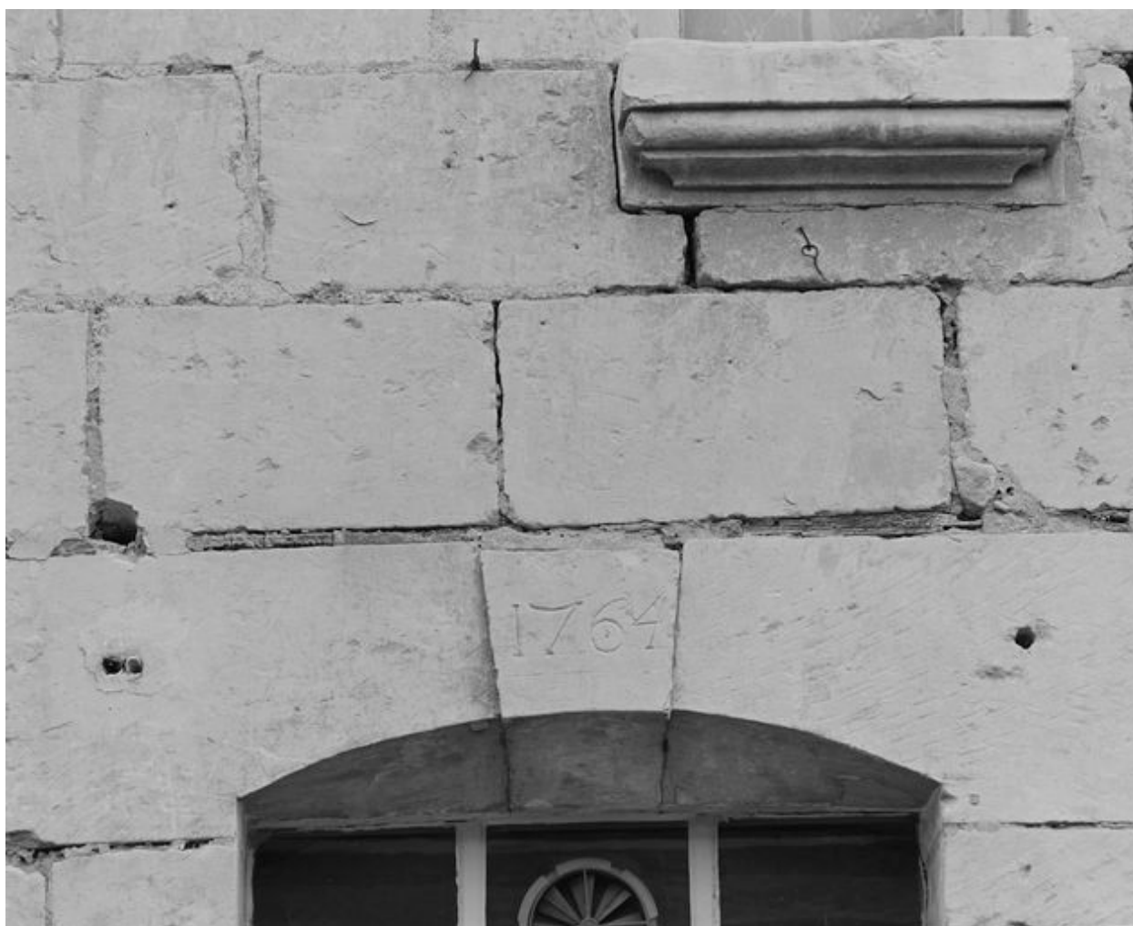
Dépendances sur cour, aile ouest (état 1996) : détail d'une baie (2e travée en partant du sud), avec date portée à la clef de la plate-bande déladée en arc segmentaire (1764).
