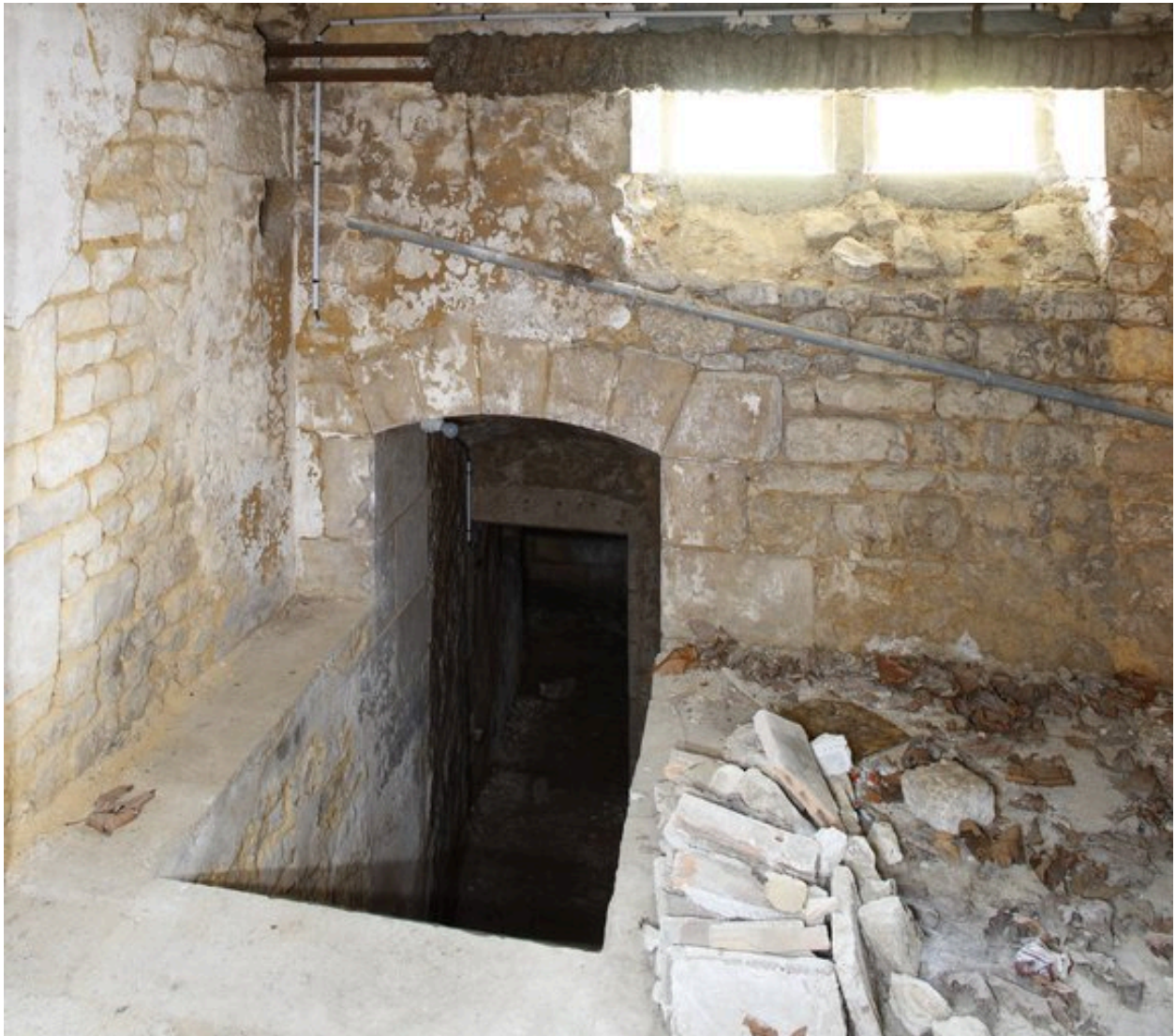
Descente de cave (vestige de la maison antérieure).
