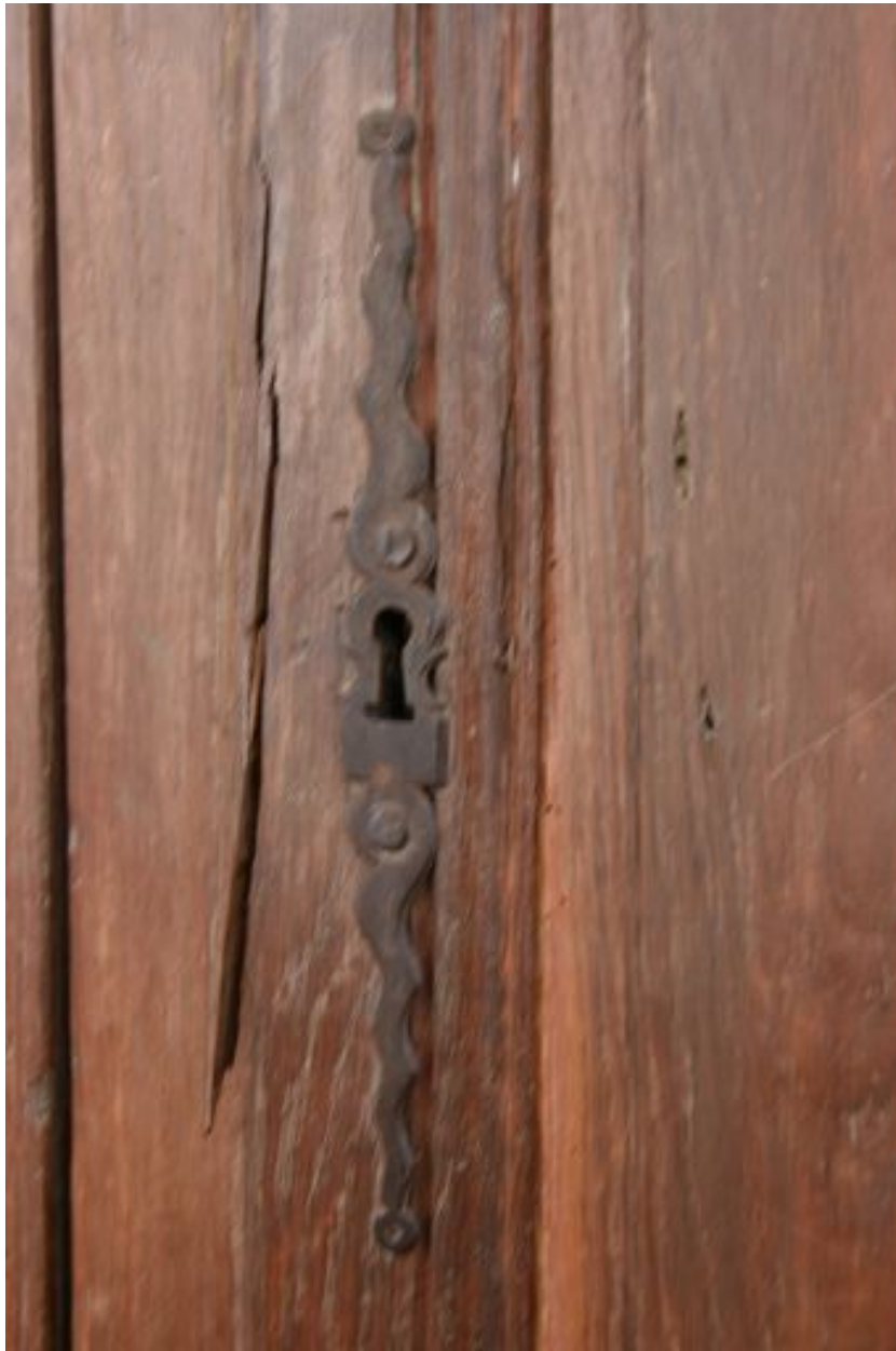
Meubles de sacristie assemblés, ferrure à gauche.
