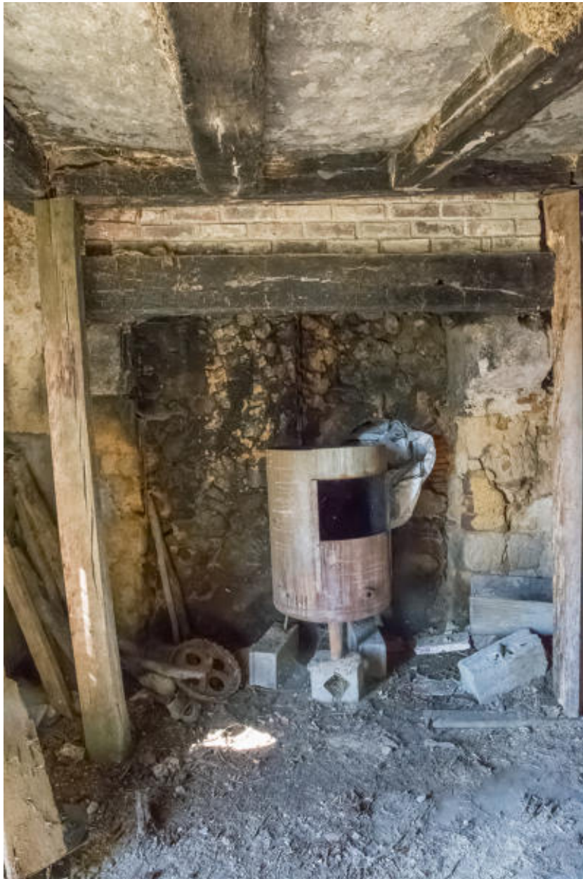
Logis ancien, pièce à feu : cheminée sans piédroits avec corbeaux anciens.
