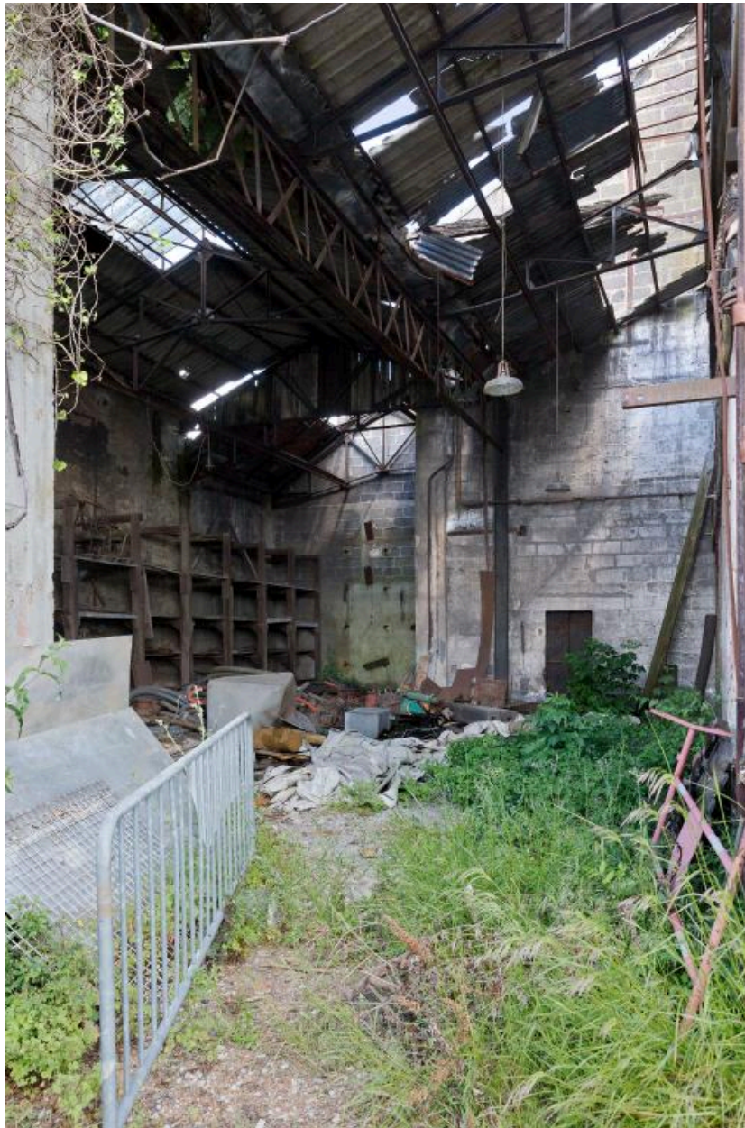
A : partie sud du bâtiment A.
