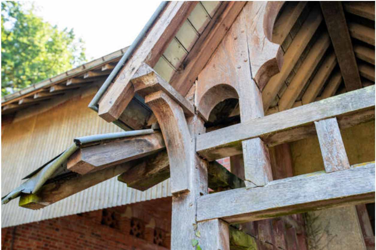
Le porche de la laiterie, détail.
