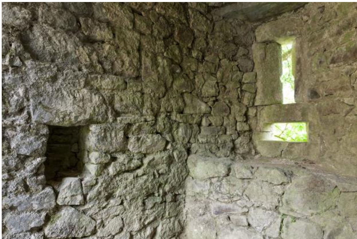
Empochement d'une barre de retrait, casemate de la galerie inférieure du boulevard.
