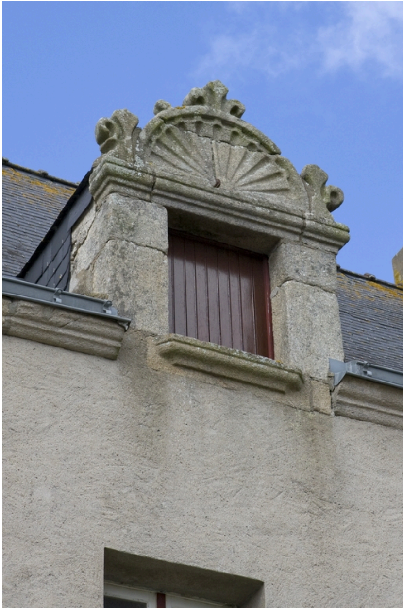
Logis. Partie ouest. Façade nord. Détail de la lucarne.
