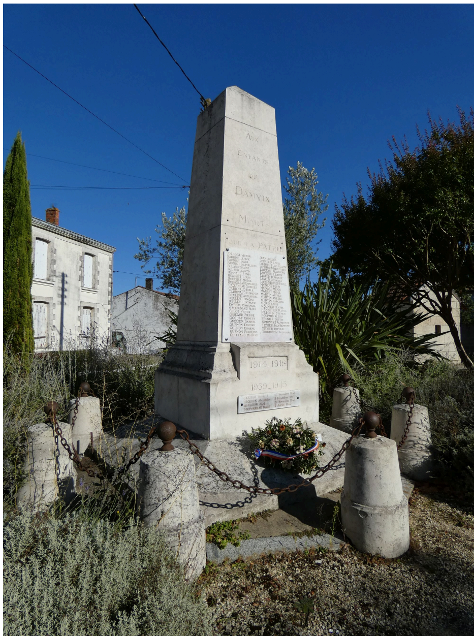
Le monument vu depuis le nord-ouest.
