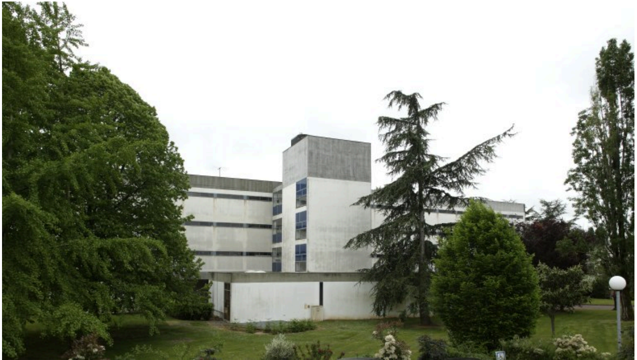
Vue prise du nord-est.
