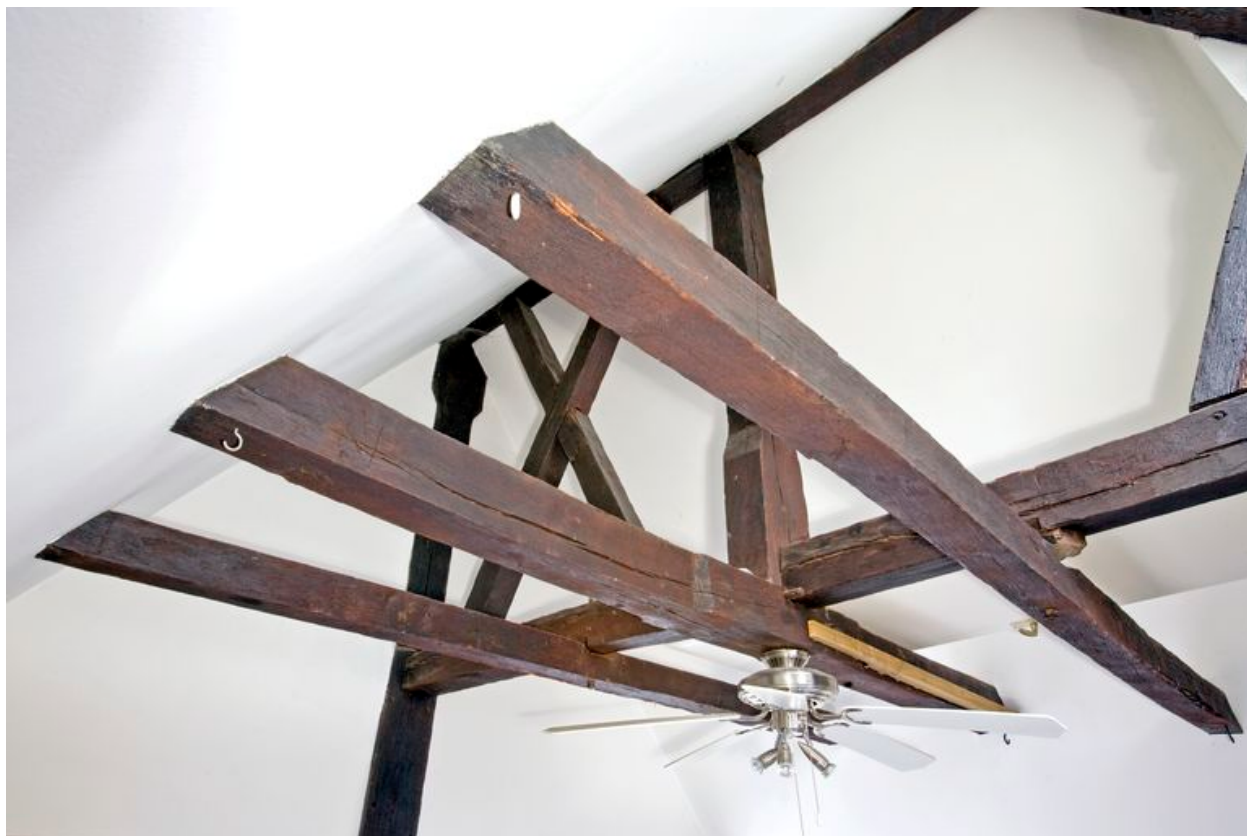
2e étage de comble, charpente : faux-entrails, poinçons et contreventement transversal à croix de St-André, vue d'ensemble depuis l'angle antérieur droit.
