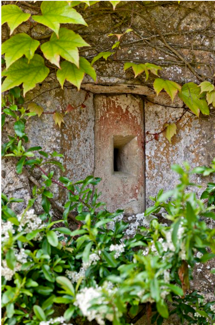
Meutrière à rotule du rez-de-chaussée de la tour, limite des XVIe et XVIIe siècles.
