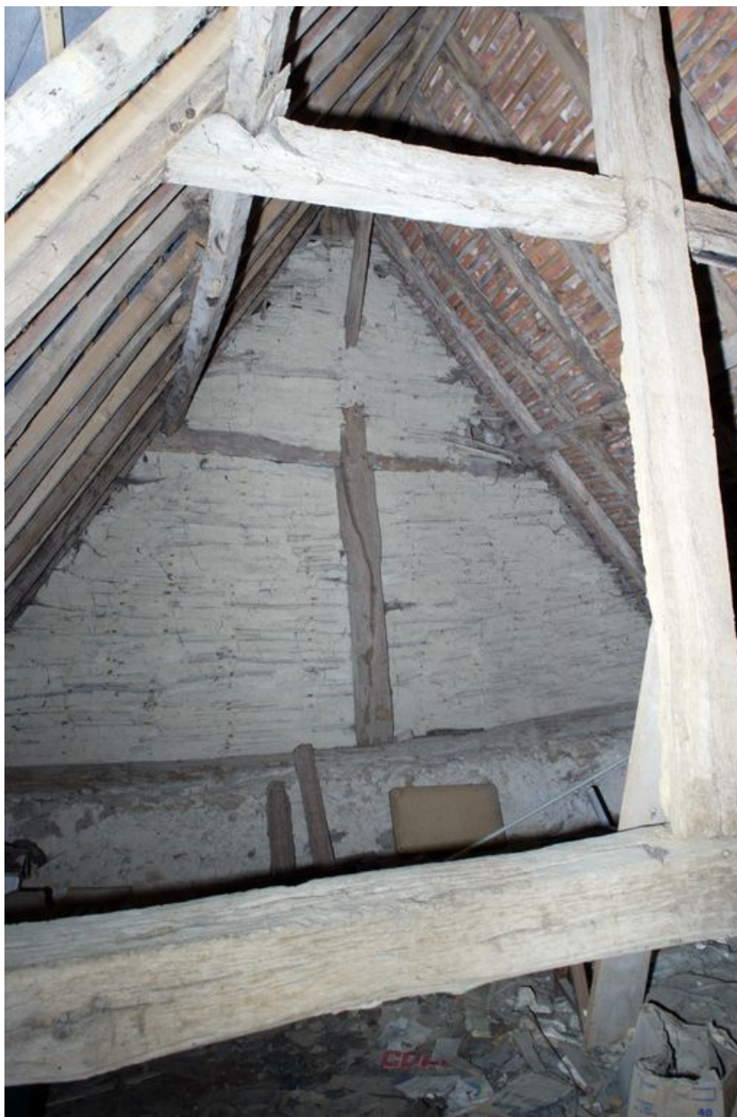
Fermes de charpente d'un des logis centraux (logis gauche) de l'alignement.
