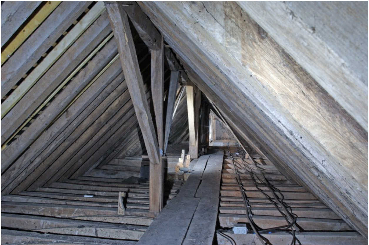
La charpente : vue de détail de la partie inférieure de la ferme principale marquée II.
