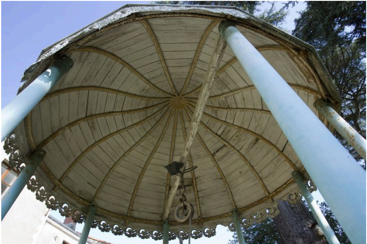
Dôme surmontant le puits : détails.
