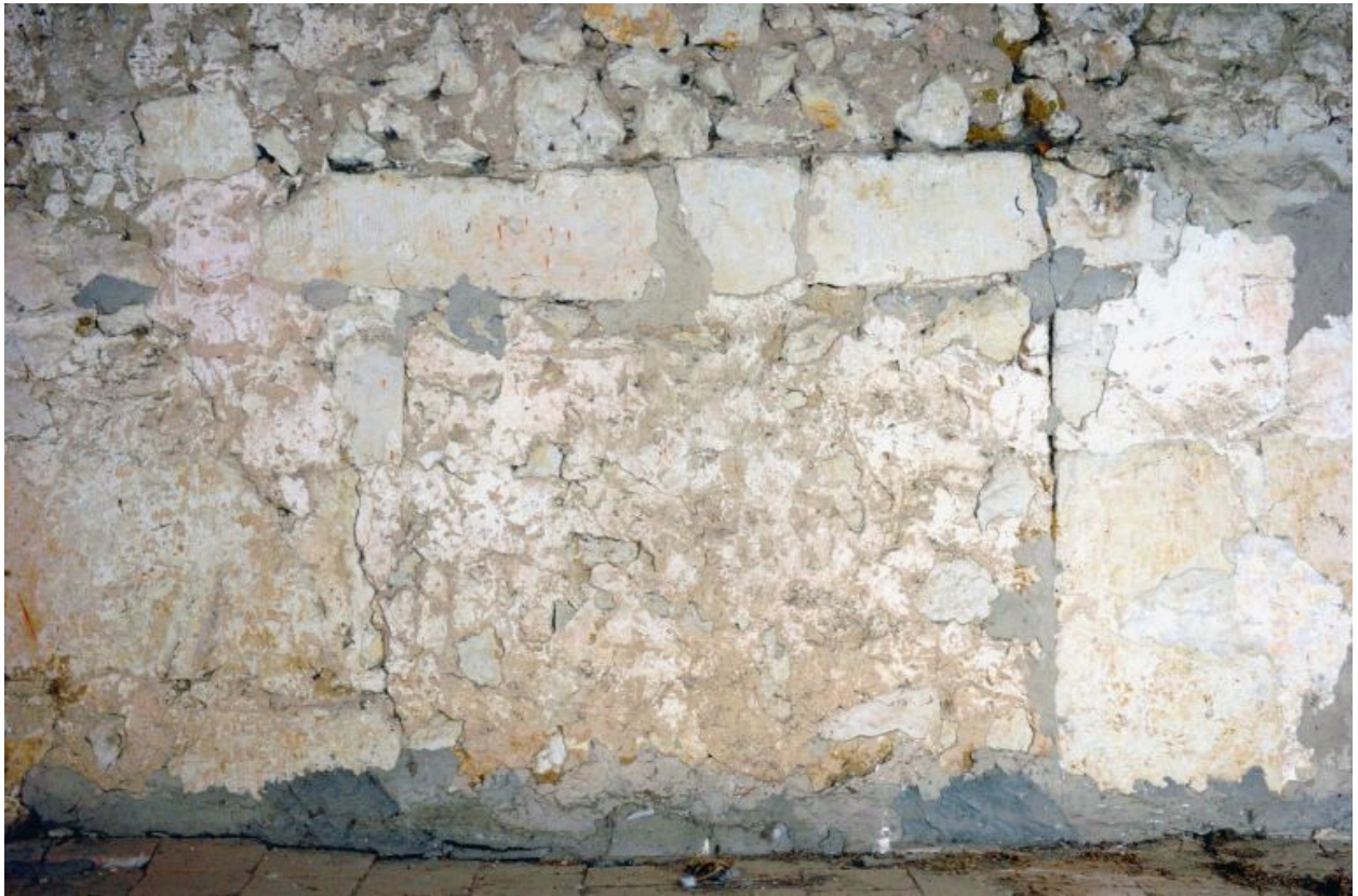
Le logis, premier étage : porte coupée.
