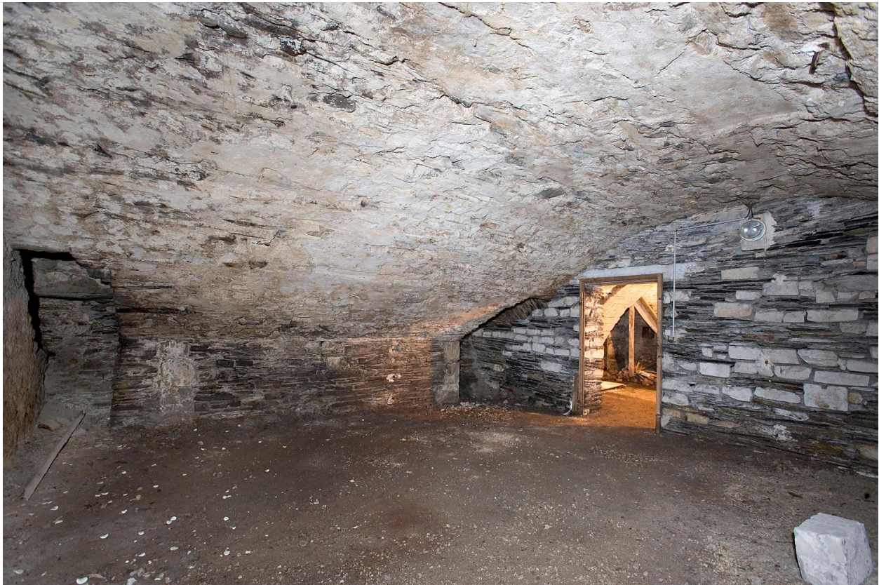
Corps de bâtiment du petit séminaire, sous-sol : cave 1, vue d'ensemble avec les faces postérieure et latérale droite.
