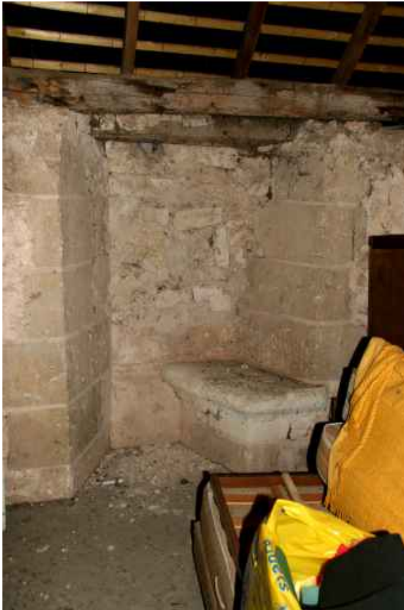
Logis annexe, 1er étage : vestige d'une demie baie à coussiège sur rue.
